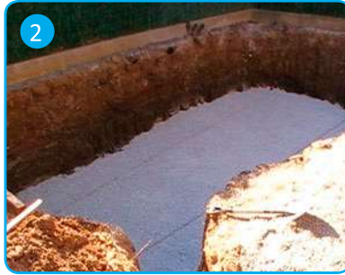
Preparación del terreno Ground preparing
