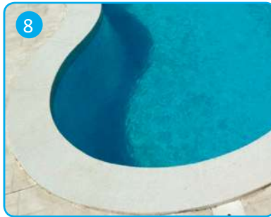
Colocación de brocales Coping stone fixing
