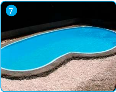
Asientos de brocales Coping stone placing
